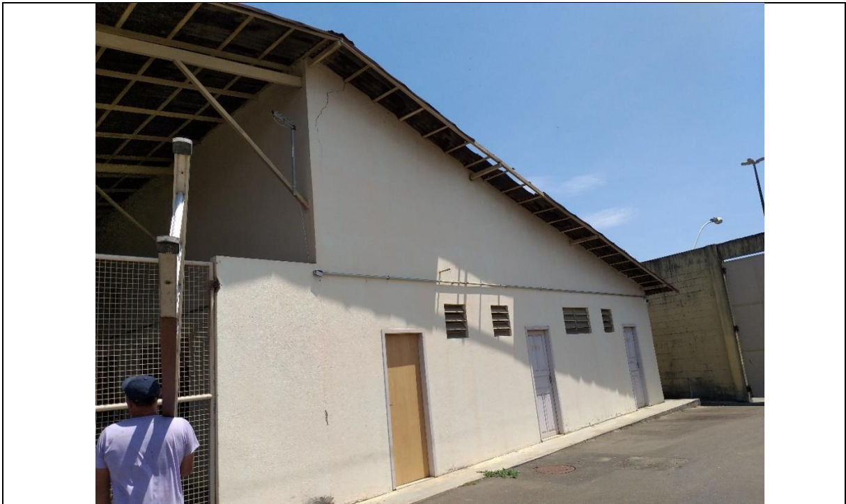
Foto 1 - Portaria do CSE: Vista geral
