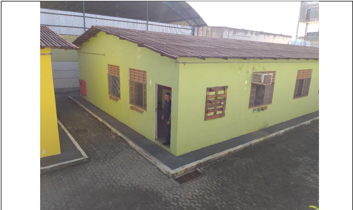
Foto 28 - UNIP II: Vista geral
