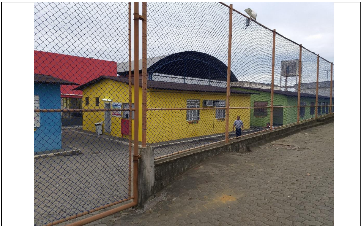
Foto 27 - UNIP II: Vista Geral
