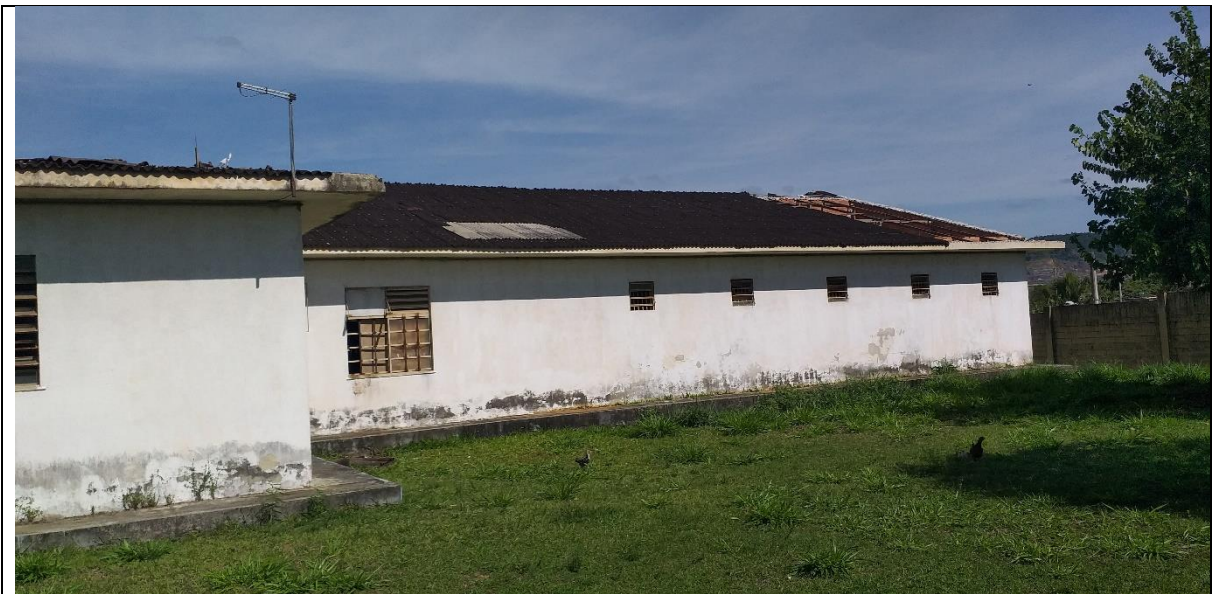
Foto 18 - CSE: Detalhe da cobertura da Moradia "Motivação"
